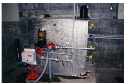
Første forsøg med 2" ekstern skyl, senere skiftet til 2" Compact AAF
